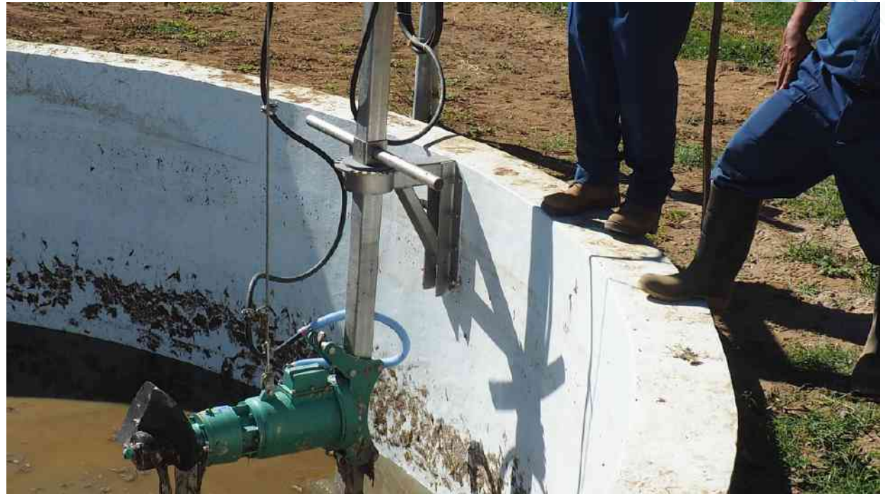
Instalación en tanque de alimentación
