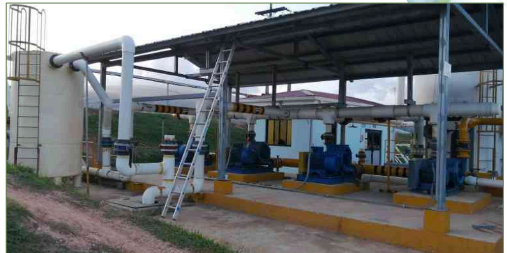
Sopladores de 60 kW en biodigestor en extractora de aceite de palma africana
